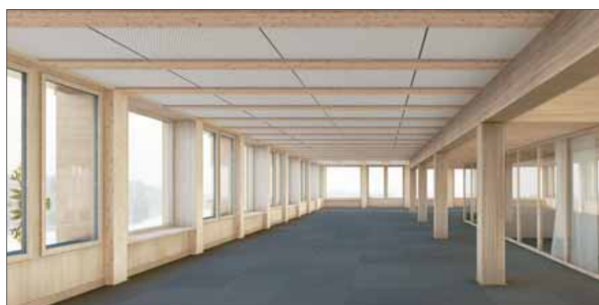
Der Skelettbau aus Buchenholz-Stützen und -Trägern bzw. das Tragsystem der Buchenholz-Beton-Verbund-Decken bleibt nach Fertigstellung im Innenraum sichtbar, wie auch die in der Fassadenebene liegenden Stützen aus Fichte oder Tanne. Foto: Kurt Schwaner
